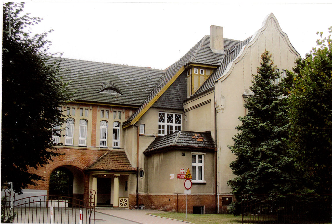
Budynek „A” (przy ul. Zamkowej)
